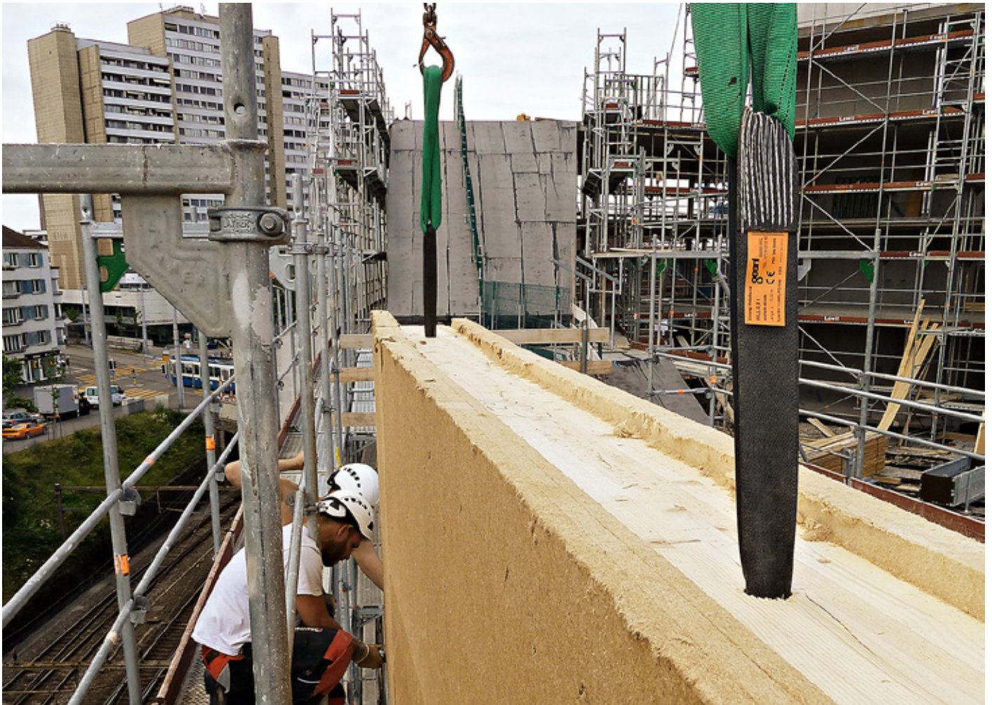
Platten mit Holzfaserdämmstoffen werden an der Mehrgenerationensiedlung Kalkbreite in Zürich montiert.
