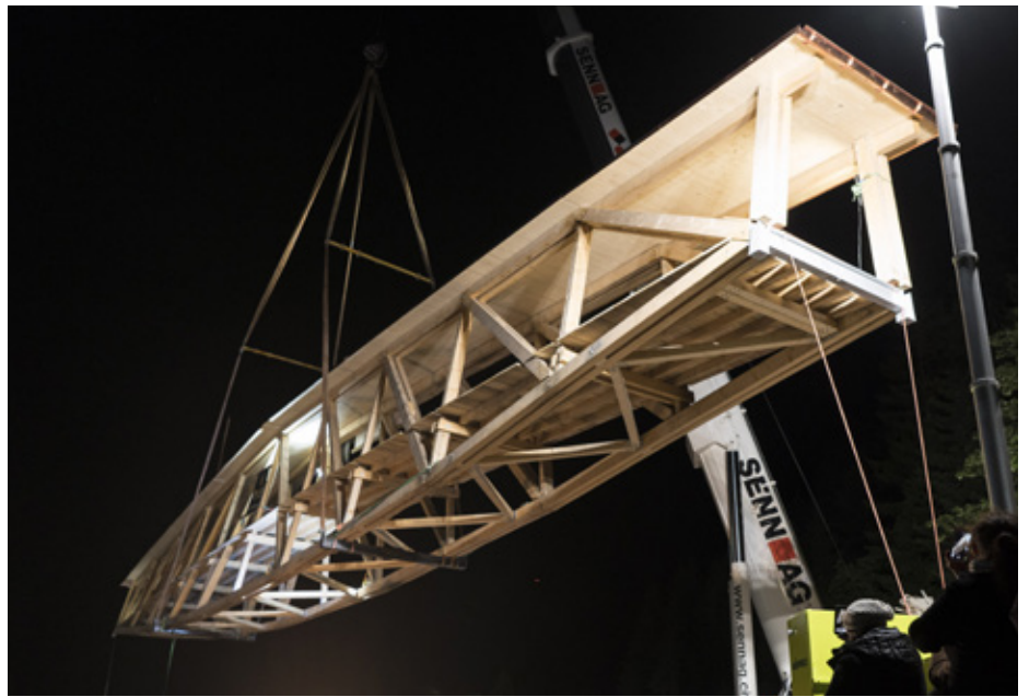
Kraftakt mit hoher Präzision: Der Mobilkran hebt die 18 Tonnen schwere Holzbrücke. Damit wurde für die Aufwertung des beliebten Kultur- und Weitwanderwegs «Via Spluga» zwischen Andeer und Splügen GR ein Meilenstein gesetzt.
