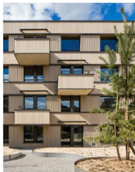
Der Holzbau in Belp wurde mit vorfabrizierten Holzelementen erstellt und mit der Flumroc-Dämmplatte 1 gedämmt.
