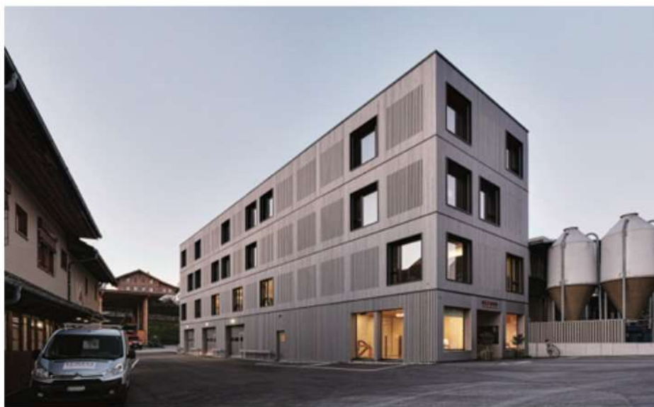
Das vierstöckige Holz-Gebäude der Remund Holzbau AG.
