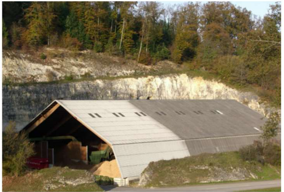
Courchavon im Jura: Grösste Schnitzellagerhalle der Schweiz.
