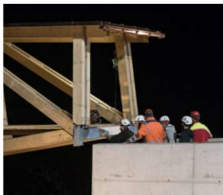
Mit Seilen bringen Zimmerleute die Brücke in die richtige Position.
