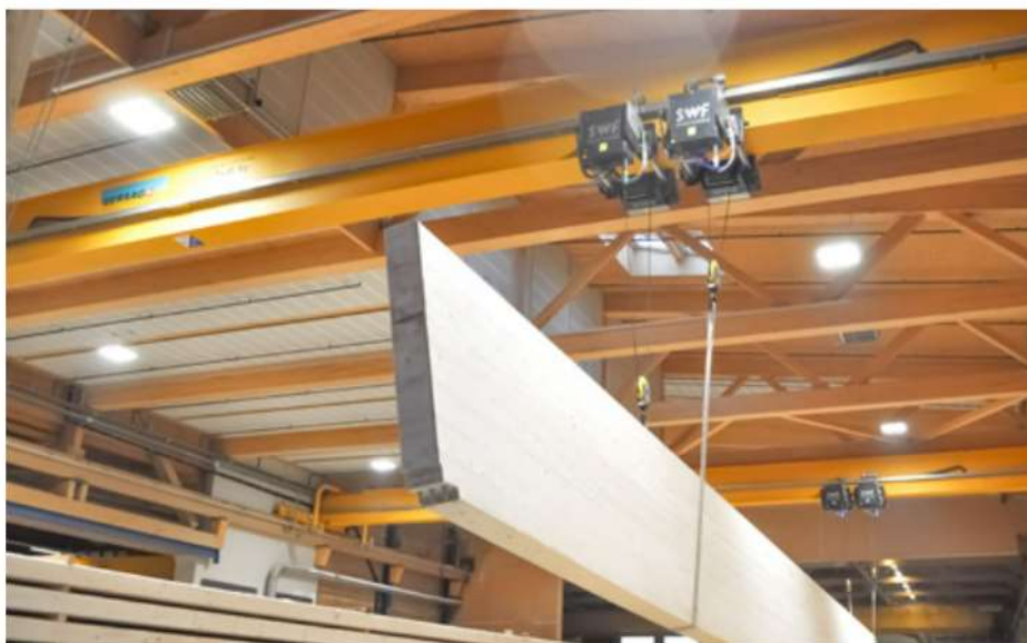
Der Holzträger wird durch das Zusammenfahren der Hubwerke gewendet.
