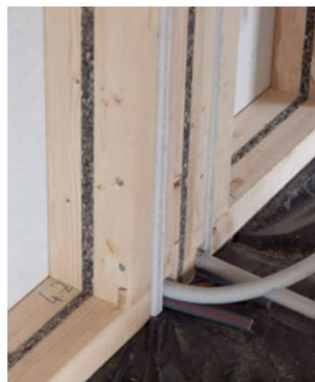
Die Montage einer Wand mit den Ständerkanteln.
